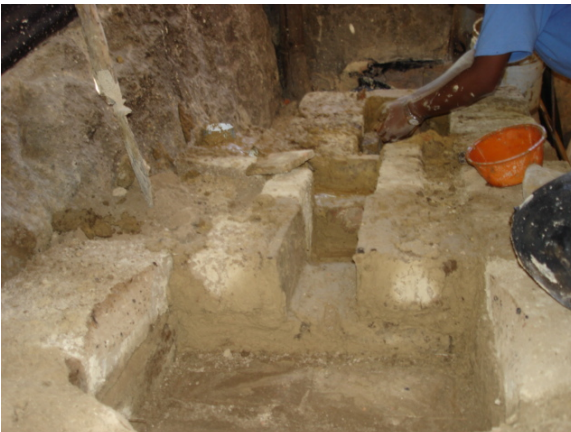
Construcción de estufa ahorradora de leña a base de bloques de adobe en la Sierra Mixe de Oaxaca.
